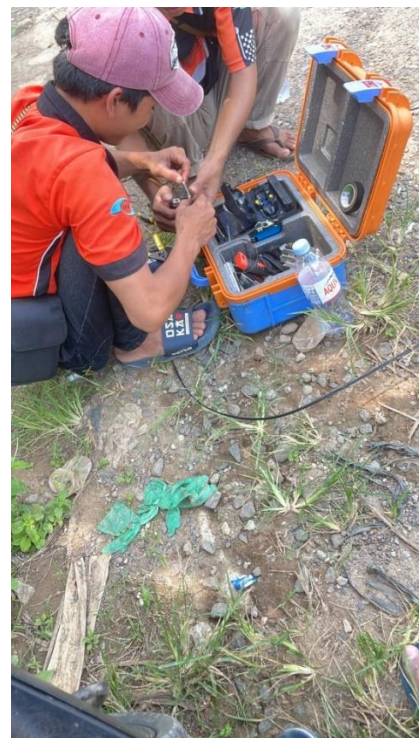
Gambar Kegiatan Teknisi LJN sedang melakukan Splicing (Penyambungan) Drop Core 1 Core
